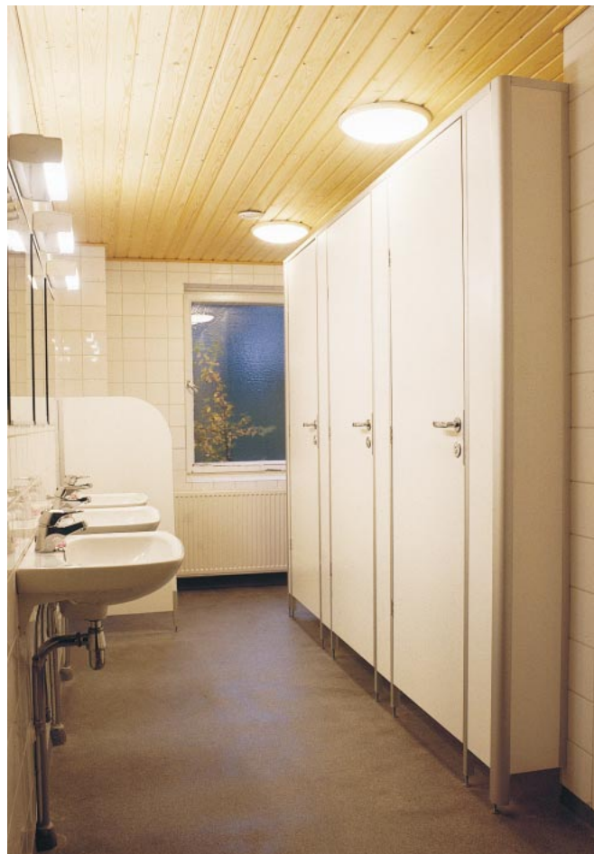
WC standard și perete despărțitor de pissoire din panel de 24 de mm.
