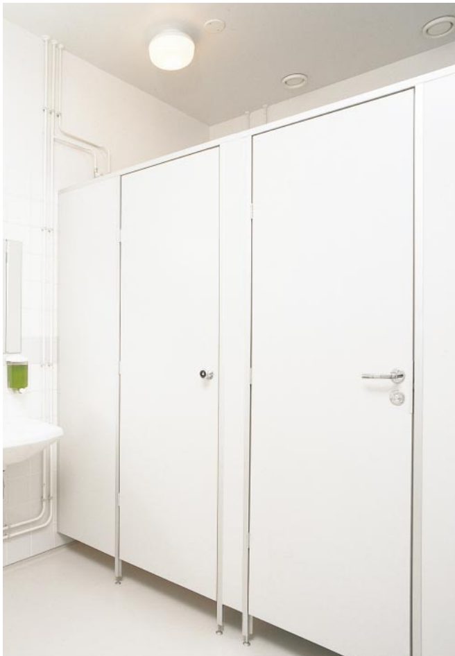
Peretele LTT de 10 mm din plăci de rășină sintetică și cabină de WC din perete de 24 de mm.
